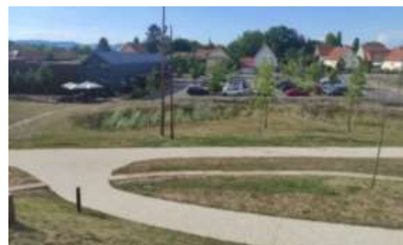
Création d'un nouveau cœur de village au sein de la commune de Seebach (67). L'un des objectifs est l'installation d'infrastructures favorisant les mobilités douces sur l'ensemble du projet.
