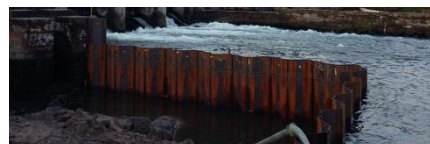
Chantier en cours de restructuration du barrage de la Steinsau protégeant Strasbourg contre les crues Maîtrise d'ouvrage Grand Est © Région Grand Est
