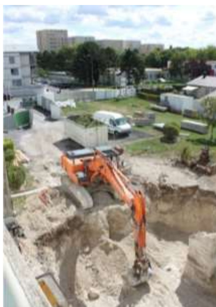
L'excavation avant construction
