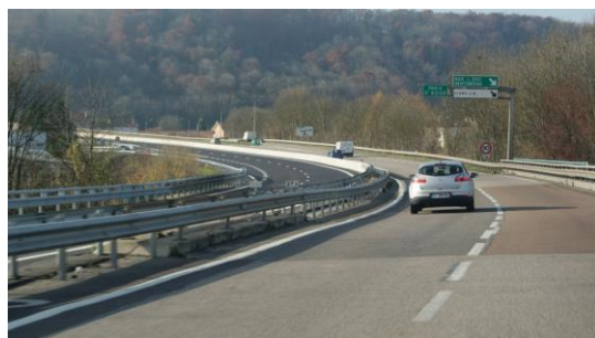
Première phase de travaux terminée à Ligny-en-Barrois
