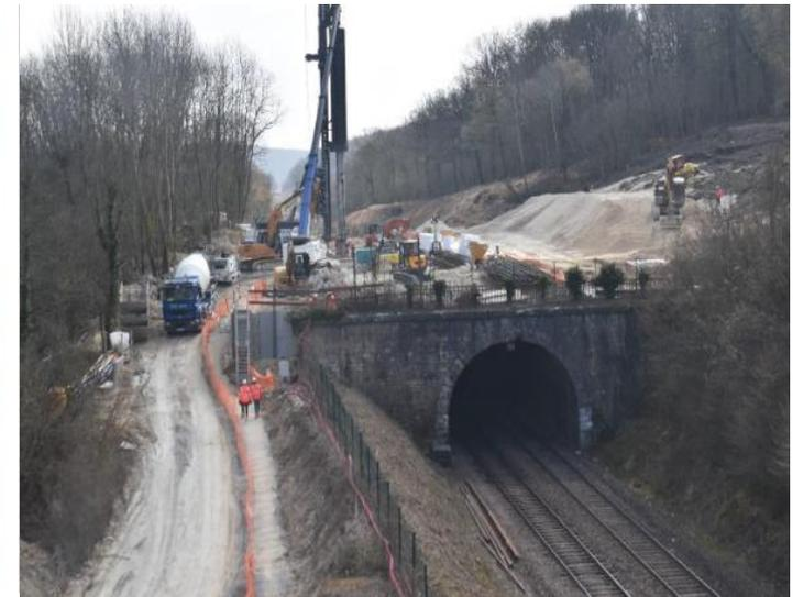
Situé sur la commune de Saint Loup-de-Naud, le tunnel actuel de 105 m, construit en 1856/1857, ne répond pas au gabarit nécessaire à l'électrification.
