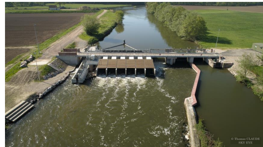
Figure 18: Barrage de la Steinsau à Erstein (protection de Strasbourg contre les crues de l'ill et production d'hydrélectricité)
