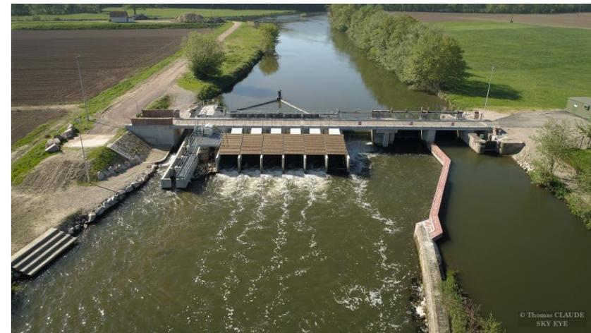
Figure 18: Barrage de la Steinsau à Erstein (protection de Strasbourg contre les crues de l'III et production d'hydrélectricité)
