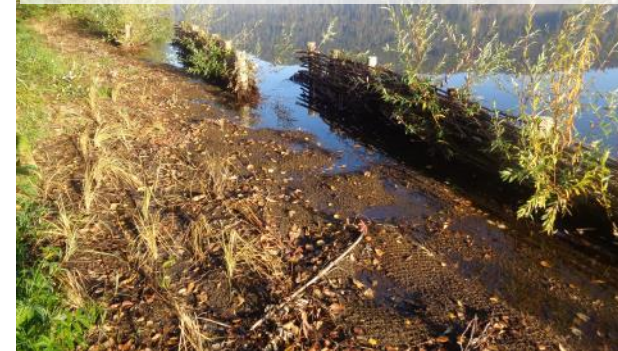
avec protection contre le batillage
