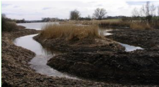
Création d'annexes hydrauliques (chenaux méandreaux)
