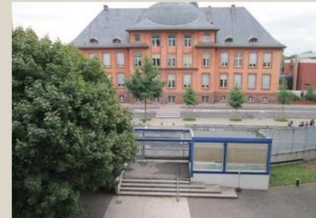
Vue du lycée Louis Pasteur situé 24 rue Humann à Strasbourg. Construit entre 1912 et 1919, le lycée a reçu le nom de Louis Pasteur à la fin des années 1960.
