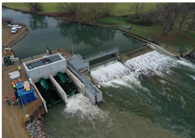
Fin des travaux en décembre 2022
