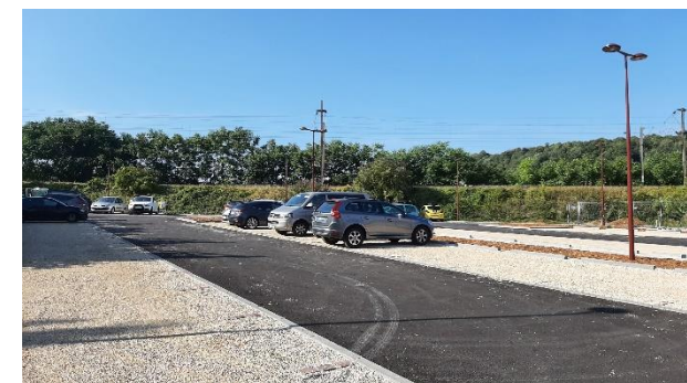
Parking Lerebourg 80 places – réalisation été 2022
