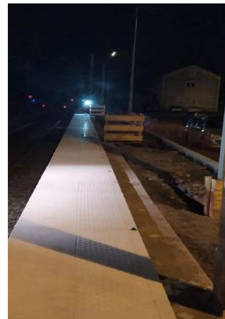
Quai1 : DEV et Bordure posées : RAF remblais, finitions et réseaux secs
