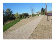
Ce revêtement perméable a deux caractéristiques : il se végétalise et est perméable à l'eau. Il est nécessaire de régulièrement le resurfacer et reniveler ce revêtement afin d'empêcher la formation de ravines ou de flaques d'eau. Le désherbage de ces espaces peut se faire avec un désherbeur mécanique, qui travaille les premiers centimètres su sol, puis qui resurface à l'aide d'un rouleau.
