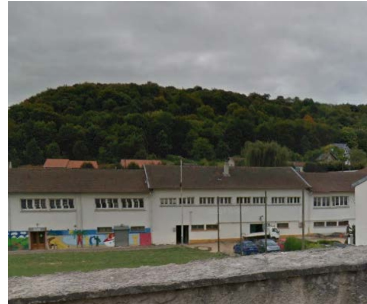
Façade nord de l'école - Source : Google maps
