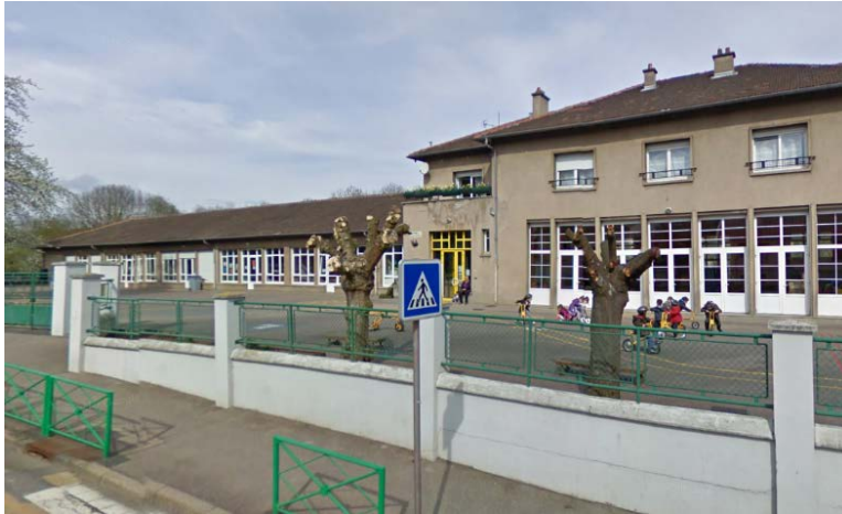
Façade sud de l'école - Source : Google maps
