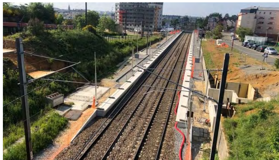
Chantier de la nouvelle halte ferroviaire Le Mans Hôpital – Source : France Bleue Pays de la Loire
