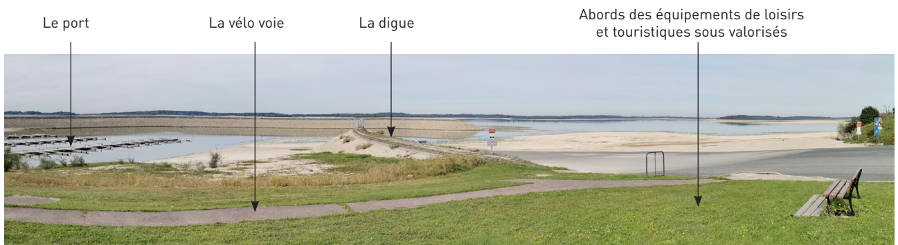
Aménagement des abords des lacs et des canaux pour le loisirs et pour la gestion hydraulique - La vélo voie de Mesnil-Saint-Père.
