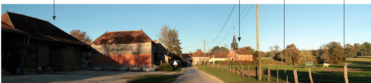
Des constructions en bois et brique dans les villages agricoles : patrimoine bâti, jardins et prairies maintenues - Loge aux Chèvres
