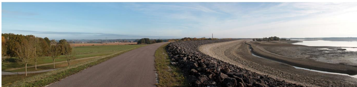
▲ La vélovie située sur la digue, composée d'une grande voie enrobée, longeant la digue et son enrochement de pierres calcaire ou gréseuses contrastant nettement avec le paysage local et contribuant à la représentation d'un objet posé complètement arbitrairement.
