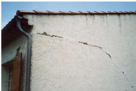
Maison fissurée en raison des mouvements de terrain induits par la rétraction et le gonflement du sol argileux. © BRGM
