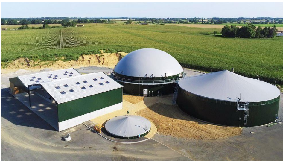
Figure 1 : Exemple d'une unité de méthanisation, source : PlanET
