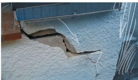
Maison fissurée en raison des mouvements de terrain induits par la rétraction et le gonflement du sol argileux. © BRGM
