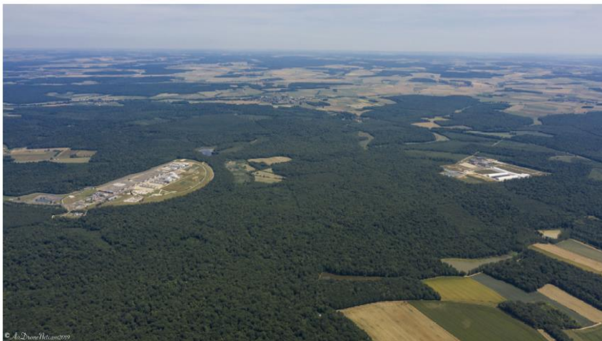
Figure 33 : Photo aérienne des 2 sites de gestion des déchets nucléaires de l'Aube – Source : ANDRA
