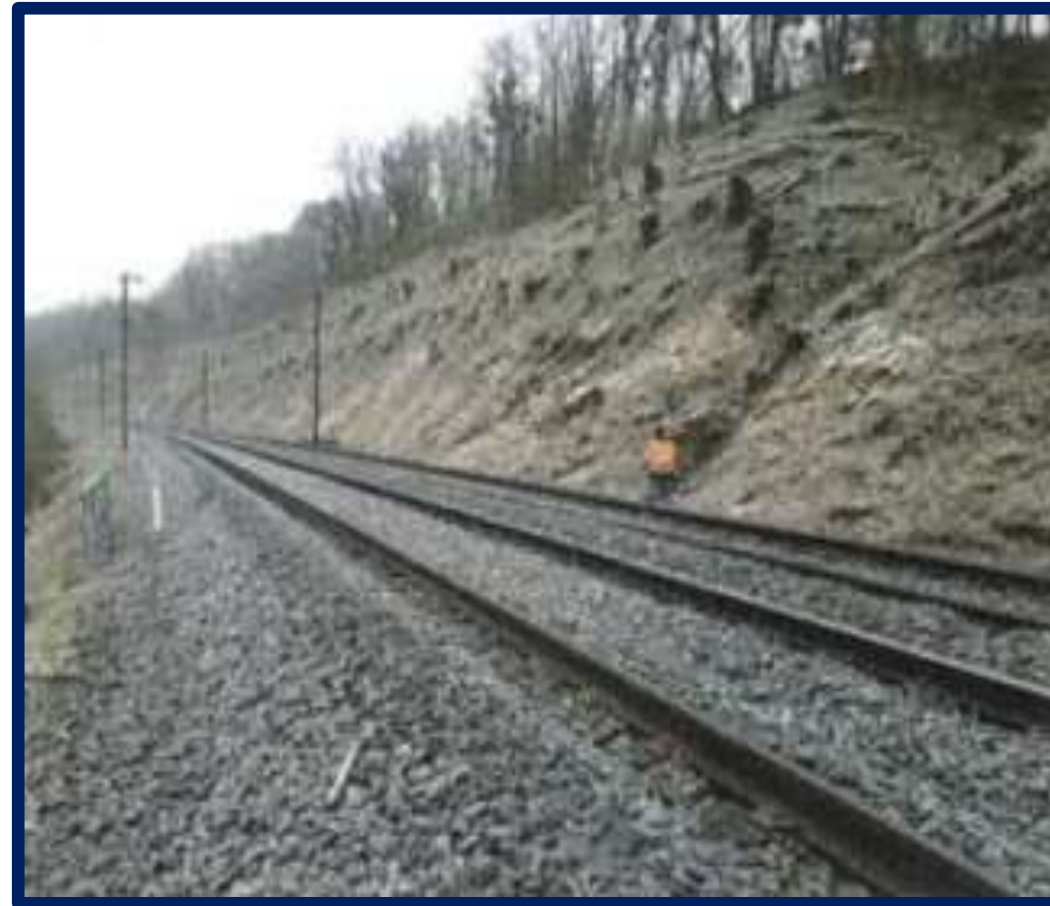
Vue d'ensemble du déblai
