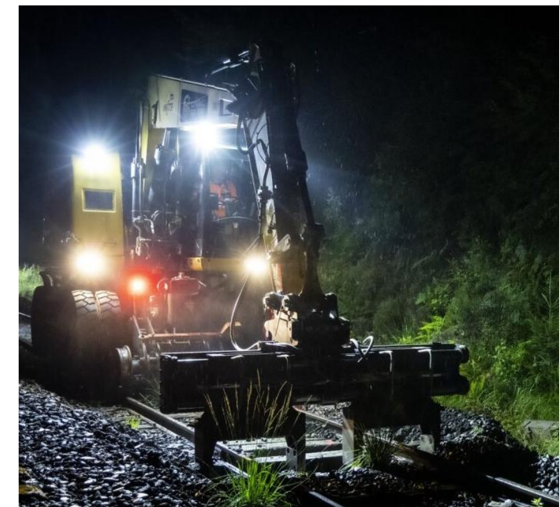
Dépose de rails - traverses
