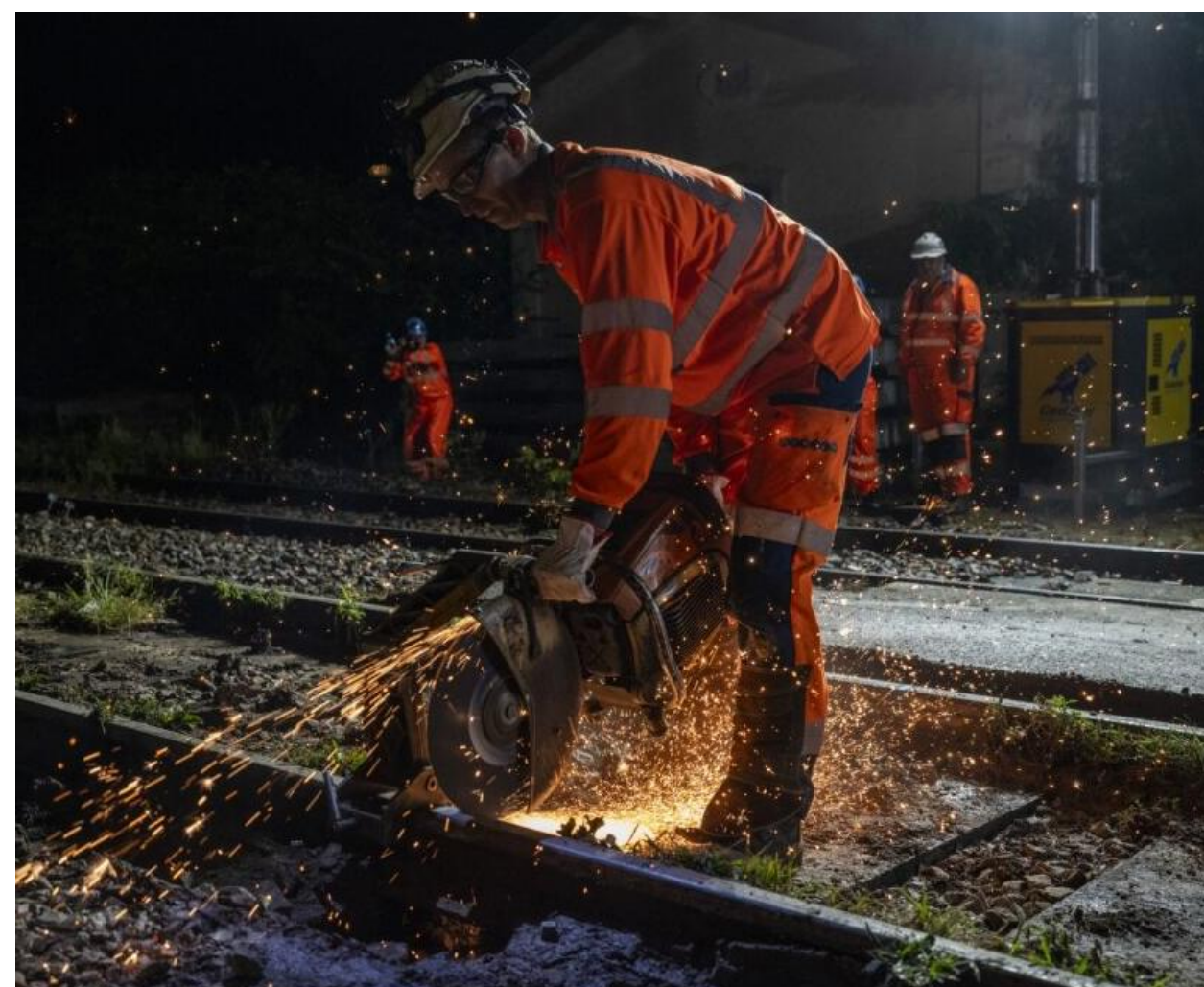
Tronçonnage de rails
