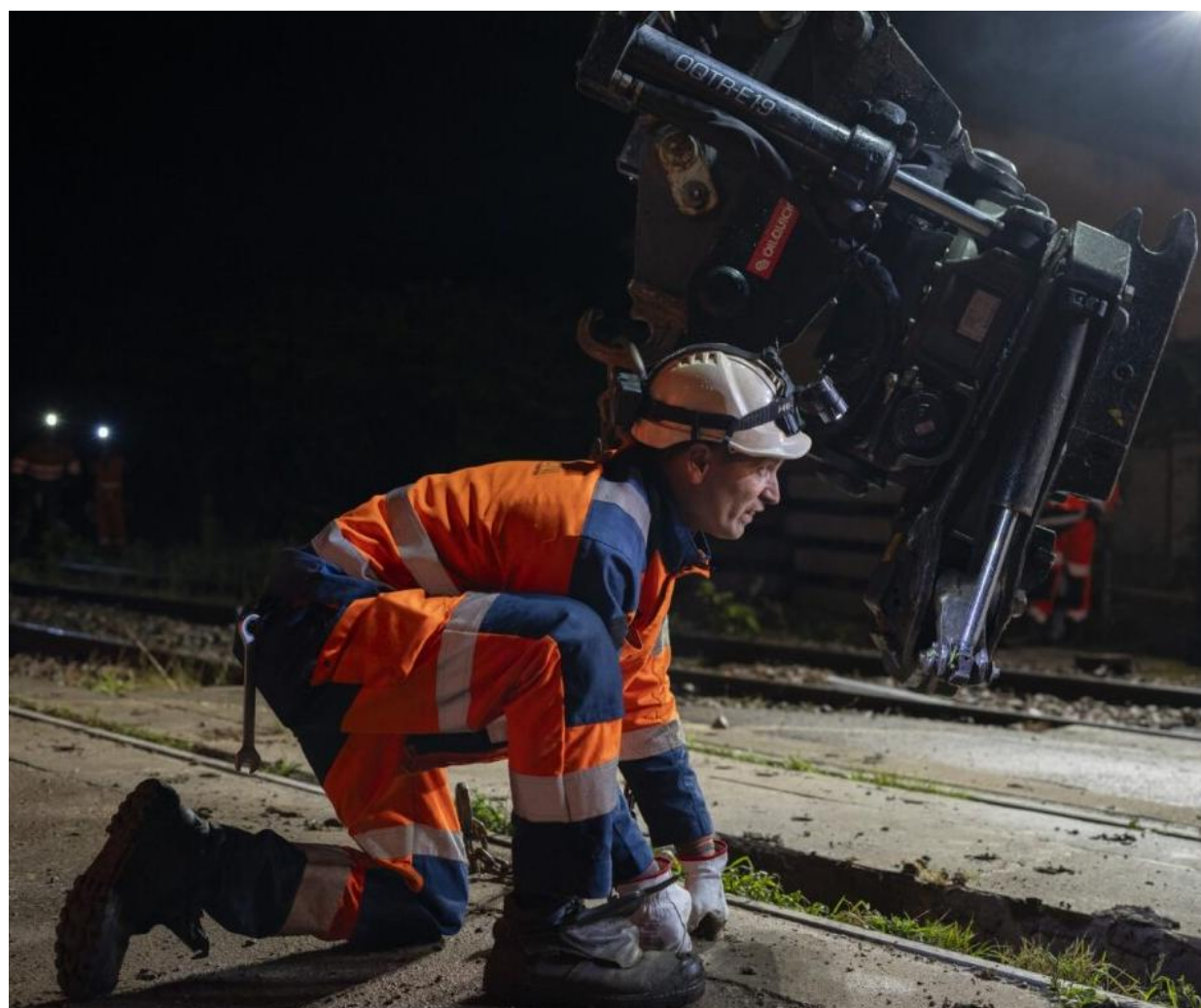
Dépose des blocs bétons d'un PN
