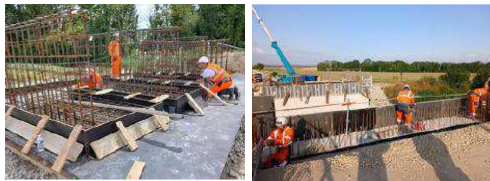
Préparation et coffrage
