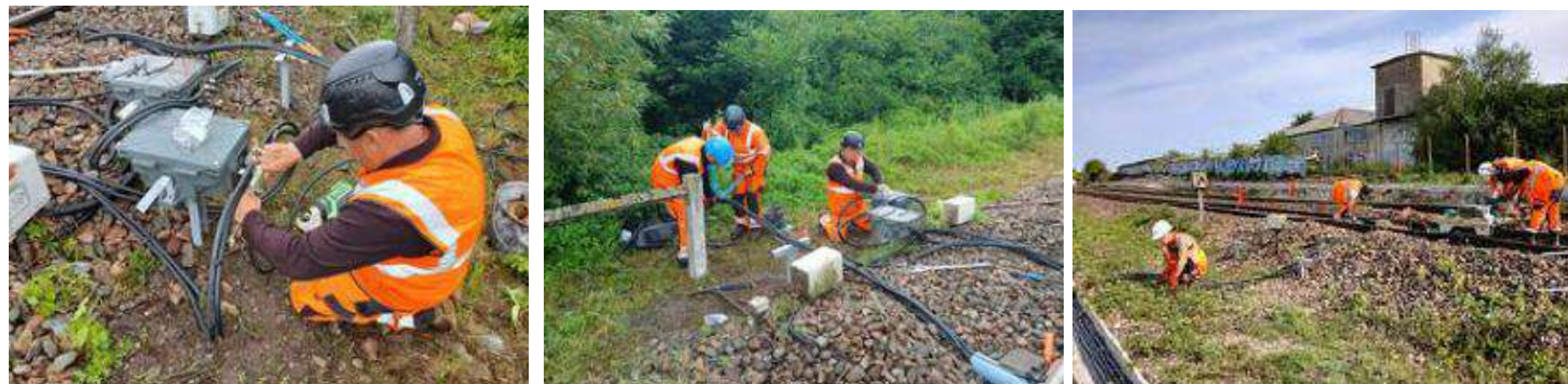
Pose de câbles et raccordement
