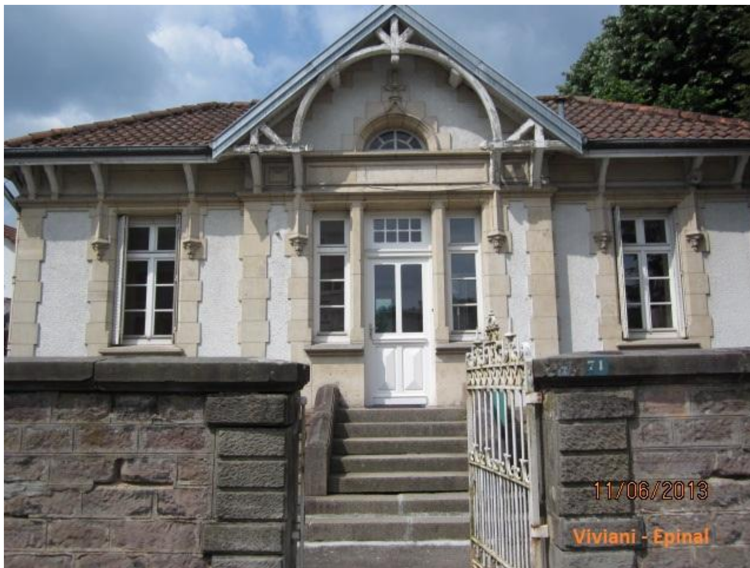
Maison d'habitation en rez-de-chaussée MS1
