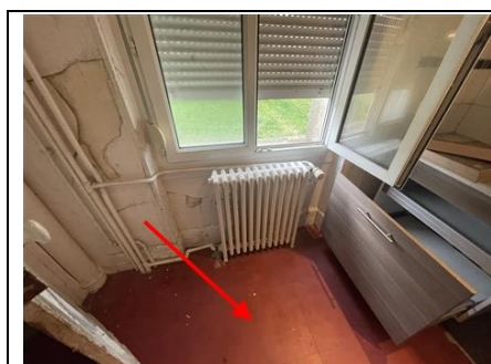
Photo n° PhA001 Localisation : Wc; Cuisine Ouvrage : 5 - Planchers et planchers techniques - Revêtements de sols Partie d'ouvrage : Dalle de sol Description : Dalle de sol
