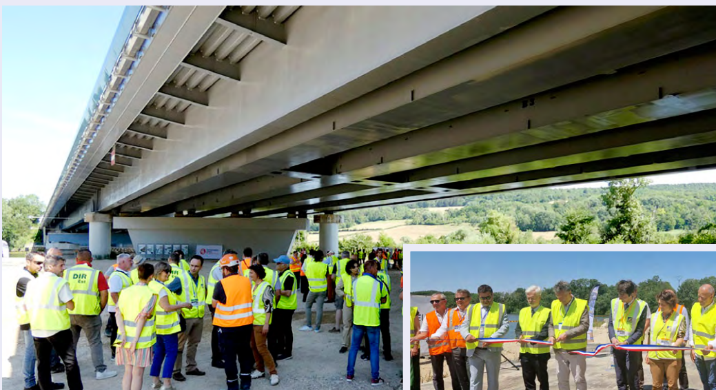
Inauguration du viaduc d'Autreville: un chantier d'envergure au service des mobilités du Grand Est
