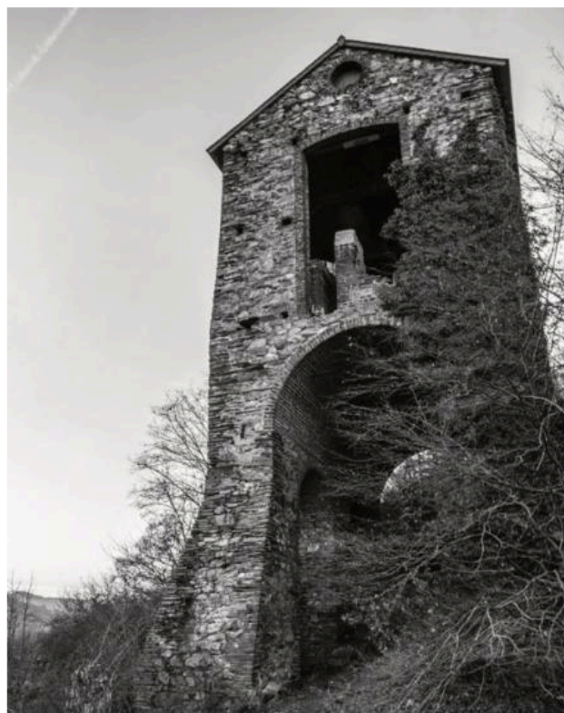
FUMAY, Ardoisière du Moulin Saint Anne, par S. BOLLICH
